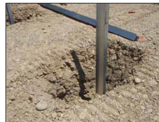
Figure 12 : Types de fondation - pieux battus (Source : Guide MEDDTL 2011 – NCA, 2015)
