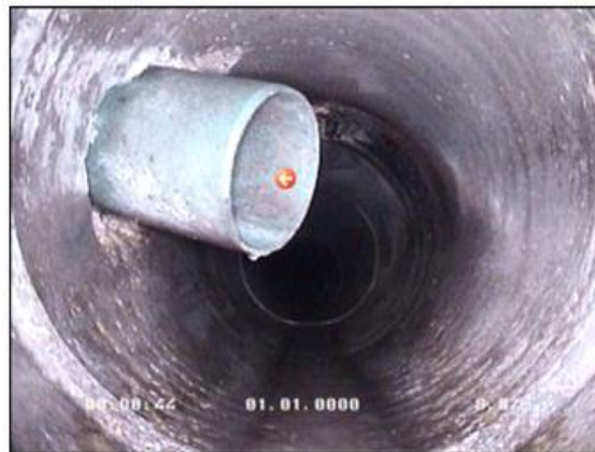
Photo: 24_24_55_A.JPG 9,3m, Branchement pénétrant à 9 h., saillie longueur de la saillie: 40 % du diamètre
