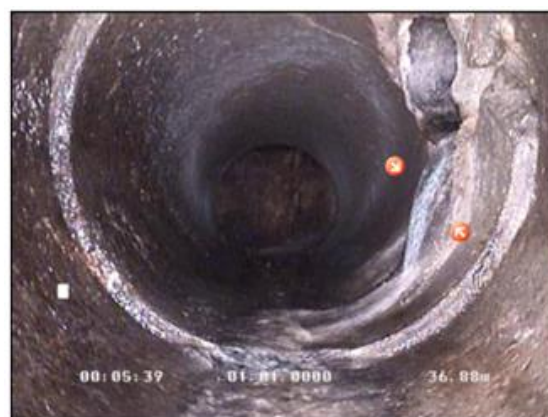
Photo: 24_24_60_A.JPG 37,3m, Selle, carottée, raccordement ouvert à 2 h., hauteur: 125 mm, (largeur: 125 mm) avec arrivée d'ECP, voir trop plein fontaine
