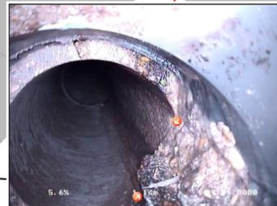
Photo: 25_25_70_A.JPG 1m, Infiltration, écoulement continu, de 4 à 8 h.
