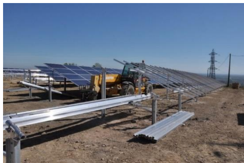
Figure 19 : Fixation des structures de montage et des modules photovoltaïques (Source : Third Step France, Damien Valette)
