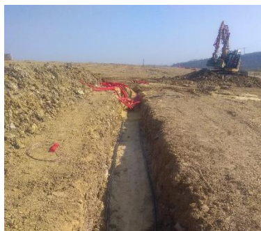
Figure 13 : Exemple de tranchée pour l'enfouissement des câbles
