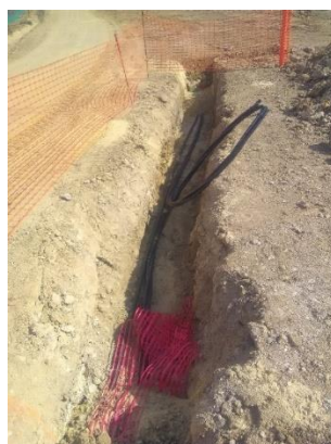
Figure 22 : Pose de câbles électriques dans les tranchées (Source : Charles Chevalier)
