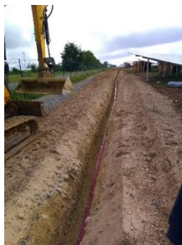
Figure 18 : Creusement de tranchées pour câbles HTA (Source : Charles Chevalier)
