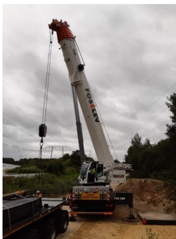
Figure 21 : Usage d'une grue pour la pose d'un local technique (Source : Charles Chevalier)
