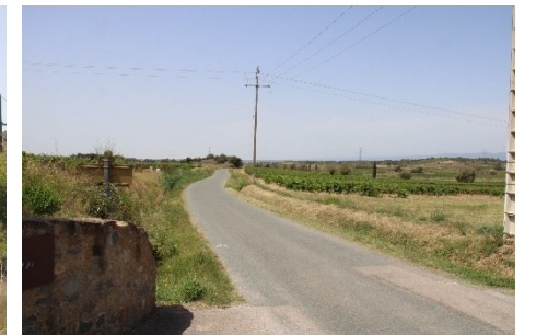
Route départementale D65 Source : ARTIFEX 2021
