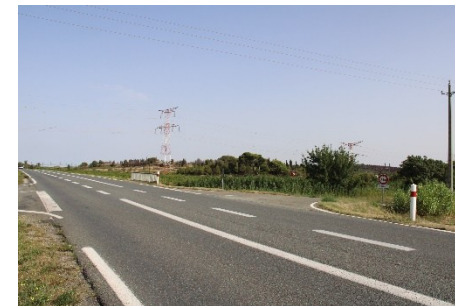
Route départementale D6113 Source : ARTIFEX 2021
