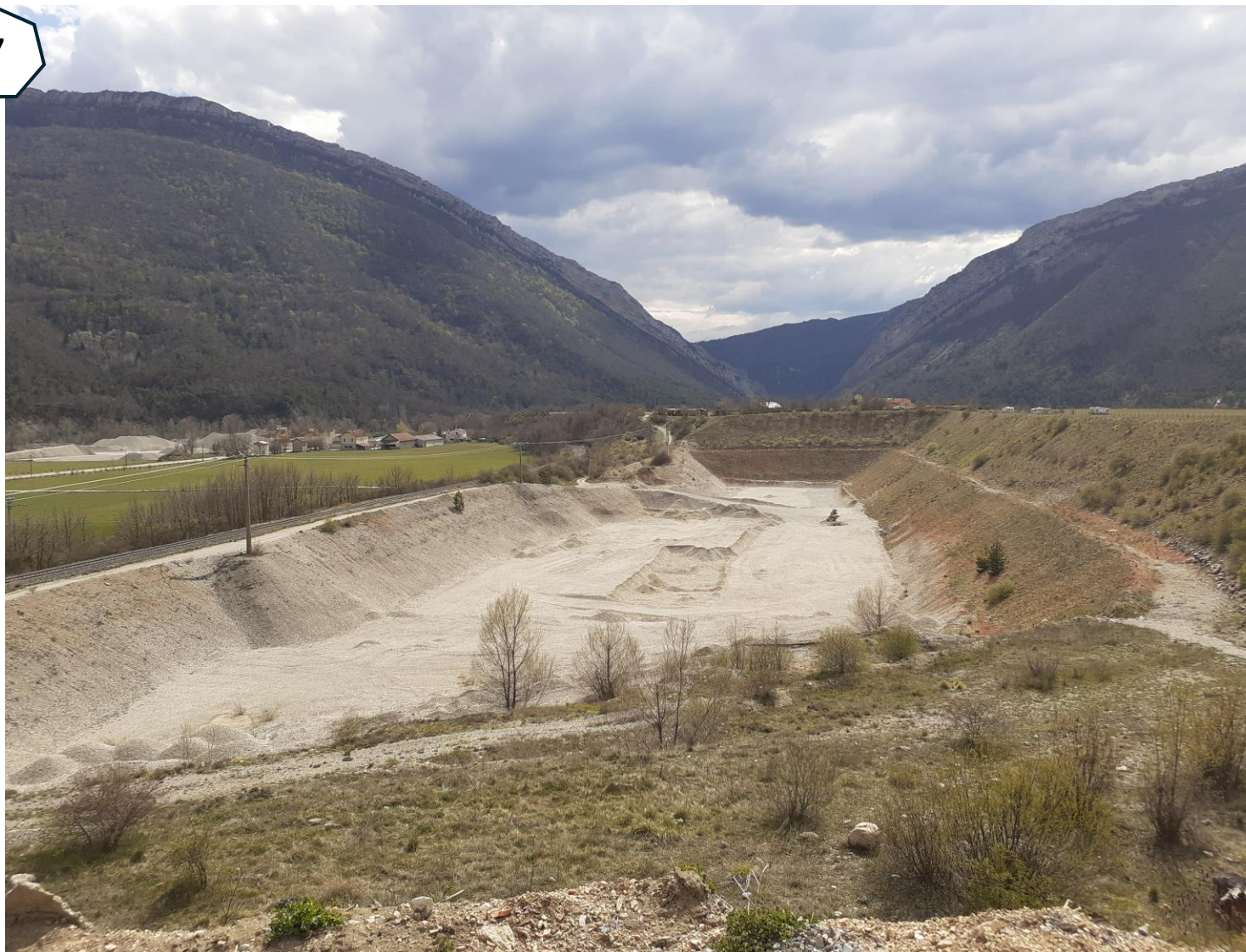
Photographie numéro 7 : Vue lointaine depuis le sentier au Nord
