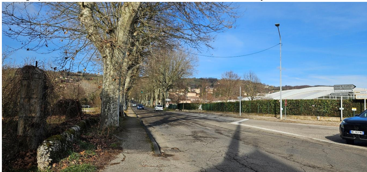
Photographie 4 – Avenue Berlioz au droit du futur carrefour Est – janvier 2026
