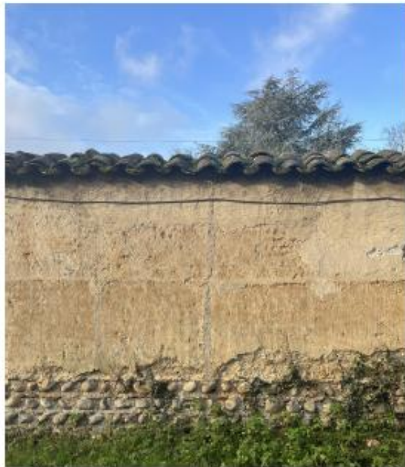
Mur existant à proximité du site
