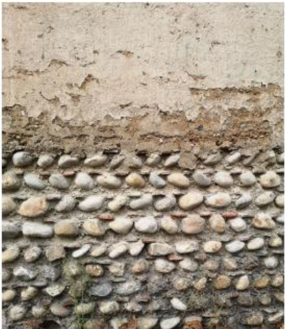
Mur existant à proximité du site
