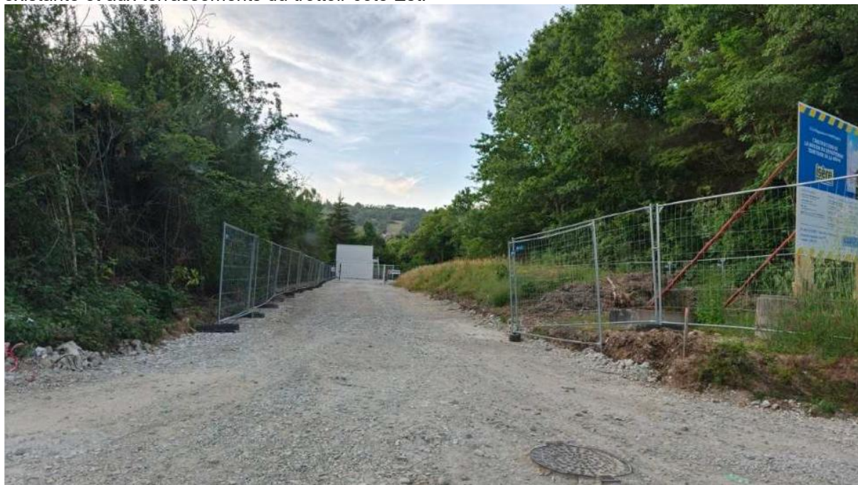
Figure 52 : Photo de l'état existant de la voirie Nord-Sud
