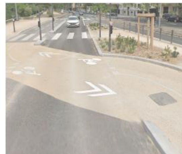
Résine sur enrobé sur les accès aux lots
