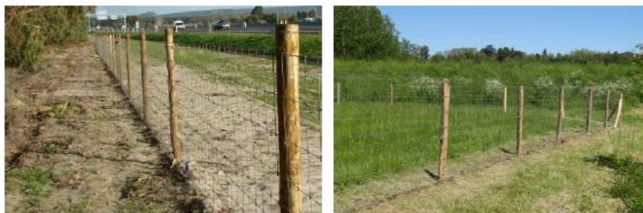
Figure 20 : Exemple d'une clôture de parc solaire
