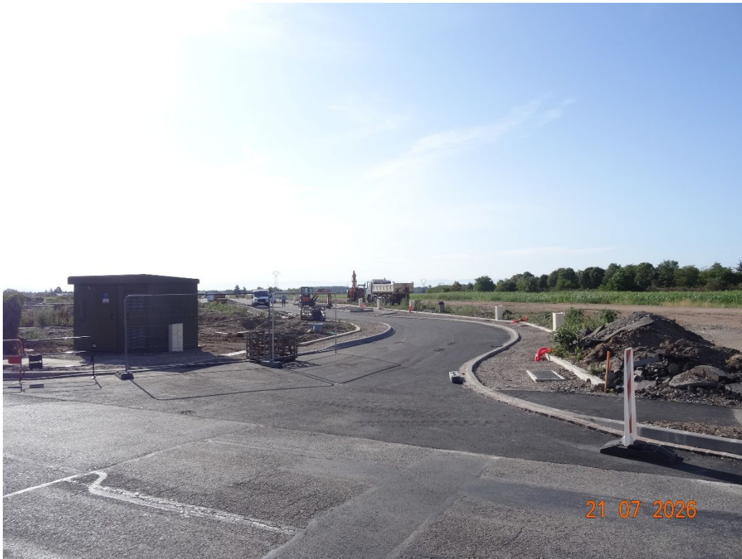
Rue du Talhuben – voie de desserte interne
