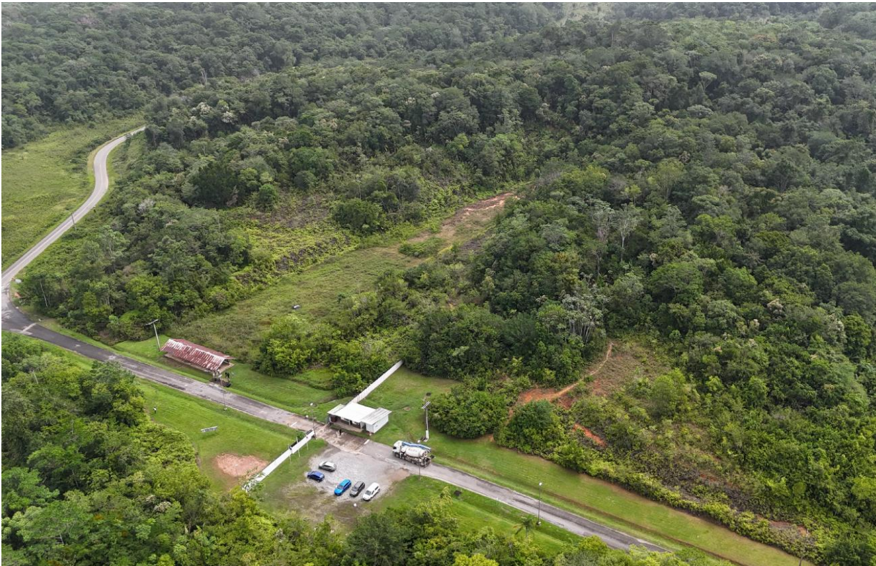
Figure 16 : Vue aérienne quartier champ de tir à l'état initial
