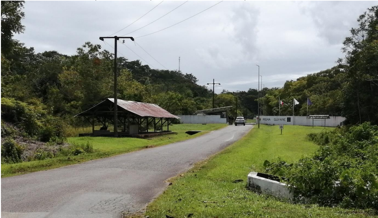
Figure 9 : Vue de l'entrée nord est du site avec le poste de contrôle
