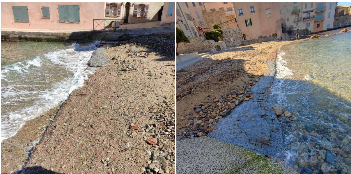
Figure 1 : Vues de la partie Est de la plage avec l'ouvrage apparent
