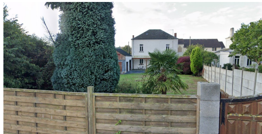
Figure 7 : Parcelle accueillant la démolition prévue pour les besoins du projet
