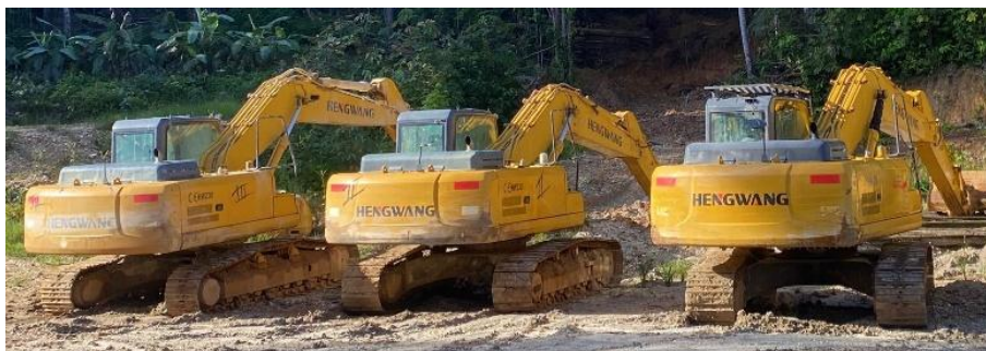
Figure 1 : Pelles à chenilles HW-220LC utilisées pour l'exploitation et la réhabilitation.
