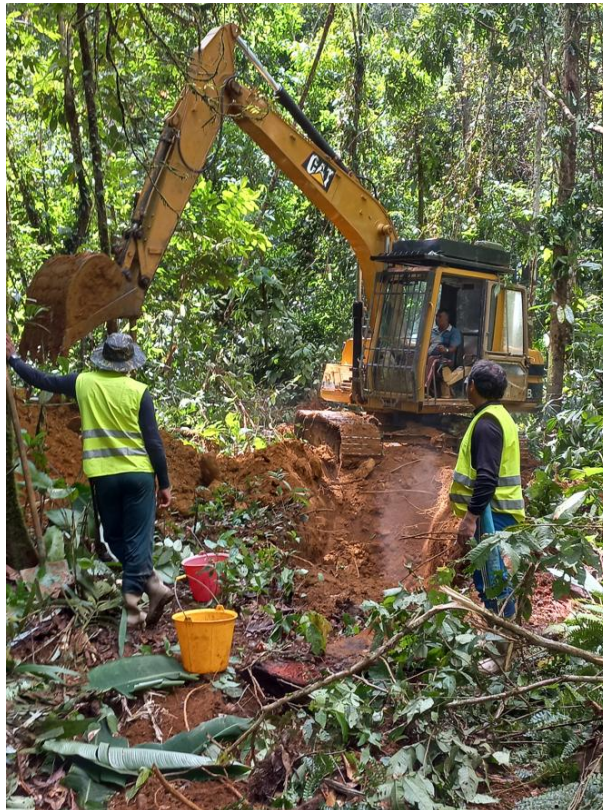
Figure 30 : Fonçage d'un puits à l'aide d'une pelle à chenilles (D. Seira, le 28/10/2021).
