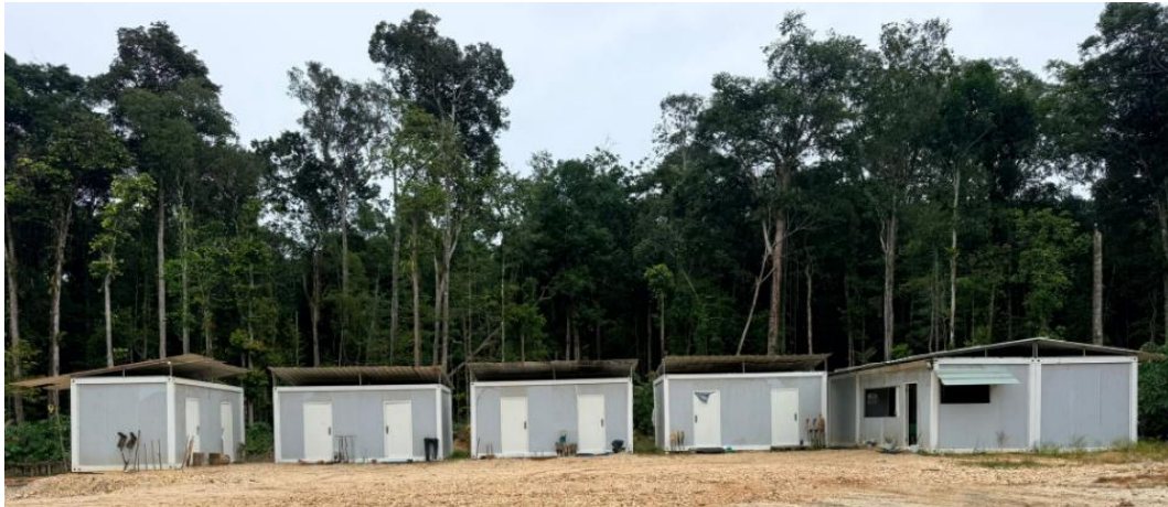
Figure 6 : Bungalows utilisés pour la base-vie du projet.
