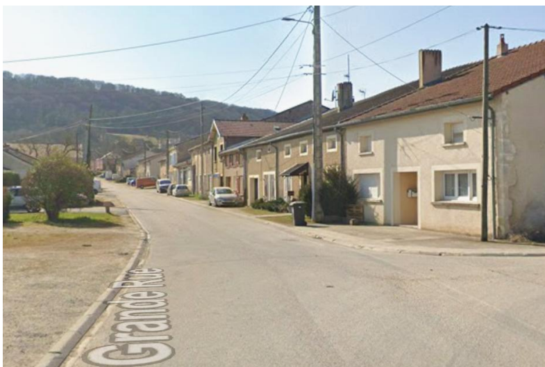
Vue de la Grande Rue de Lagney
