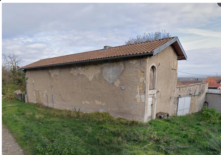
Vue du bâtiment édifié sur la parcelle AB 758
