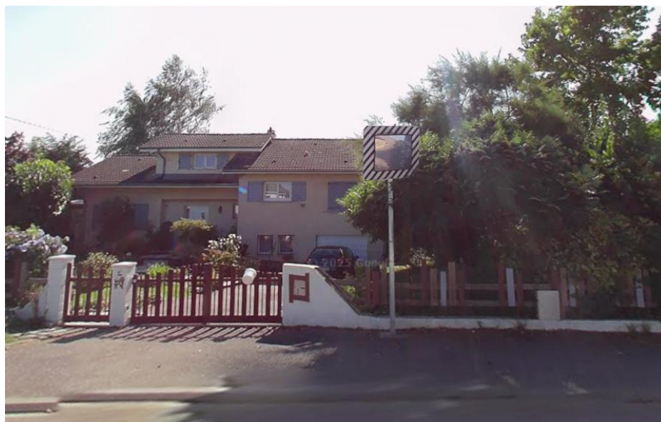
Vue de la maison édifée sur la parcelle AA 573
