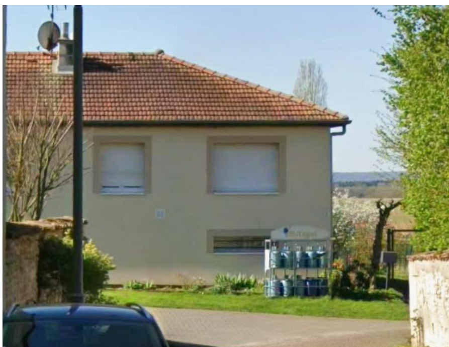
Vue de la maison édifée sur les parcelles AA 281 et 282
