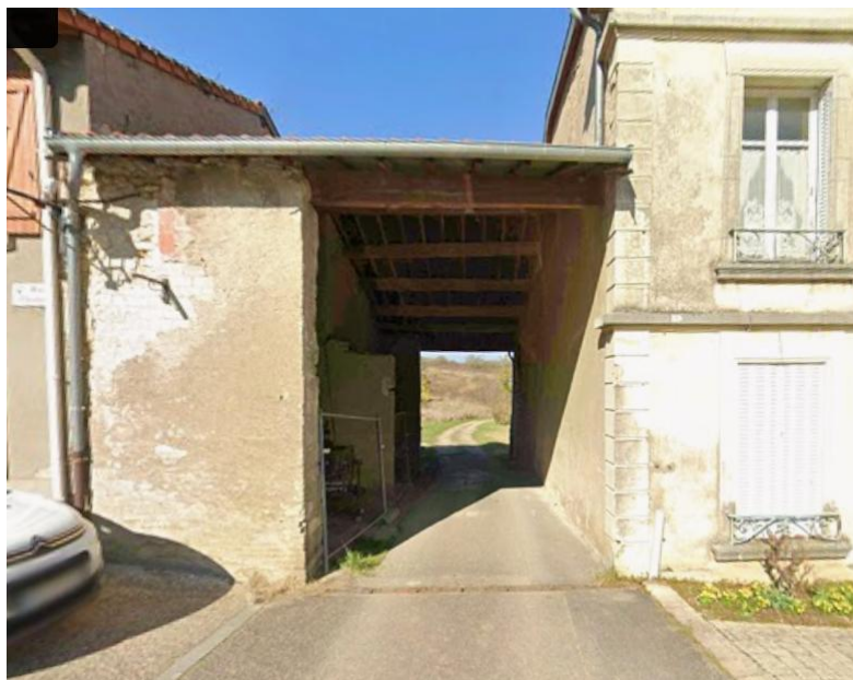
Vue du chemin permettant de relier la parcelle AB 758 à la rue Chanzy
