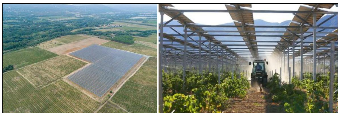
Démonstrateur agrivoltaïque de Tresserre (66) – Domaine de Nidolères
