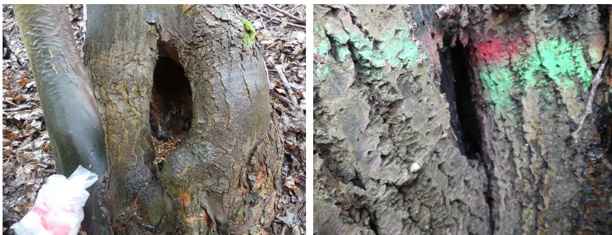
Exemples de cavités observées sur la zone de travaux
