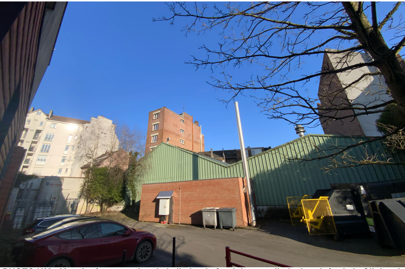
PHOTO N°2 - Vue du tènement depuis la limite de fond de parcelle (voie privée de la Clinique)
