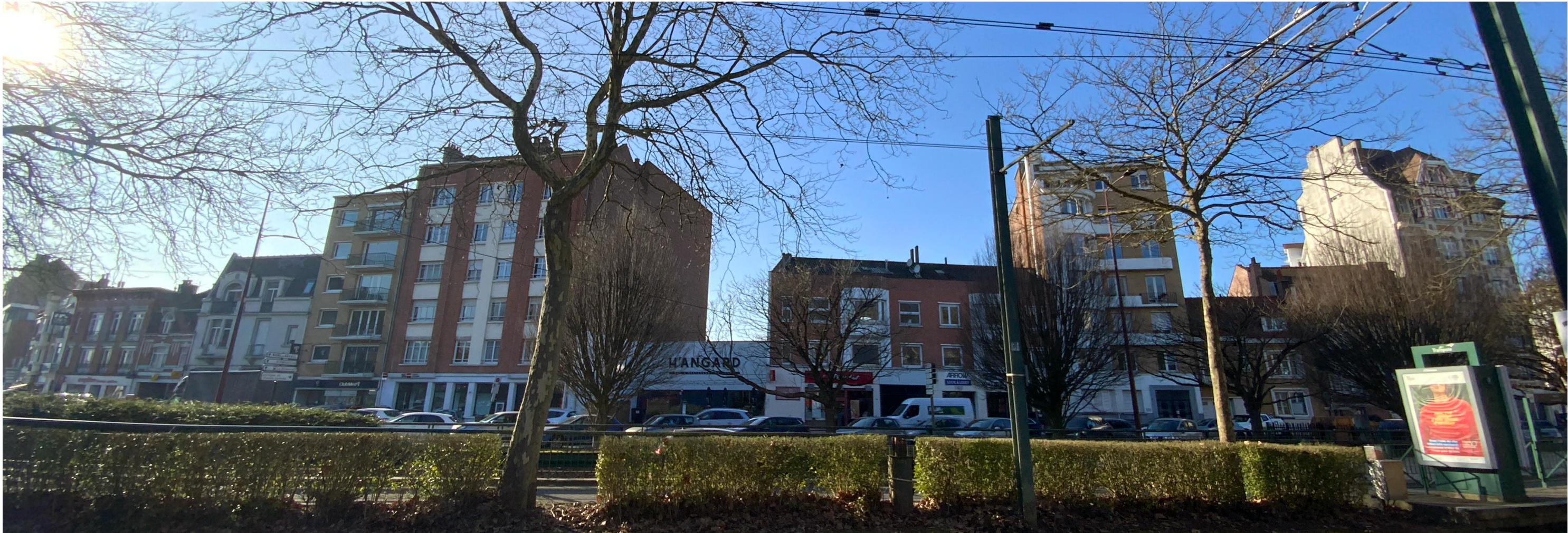
PHOTO N°3 - Vue depuis l'Avenue de la République
