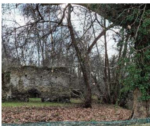
Ruine en rive droite de la Jalle, exemple d'habitat anthropique favorable pour le gîte des espèces fissuricoles peu exigeantes.
