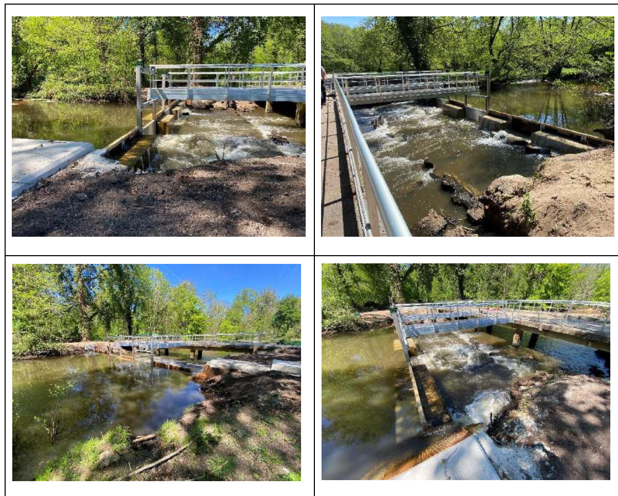
Figure 5 : Photographie de l'ouvrage palplanche terminé
