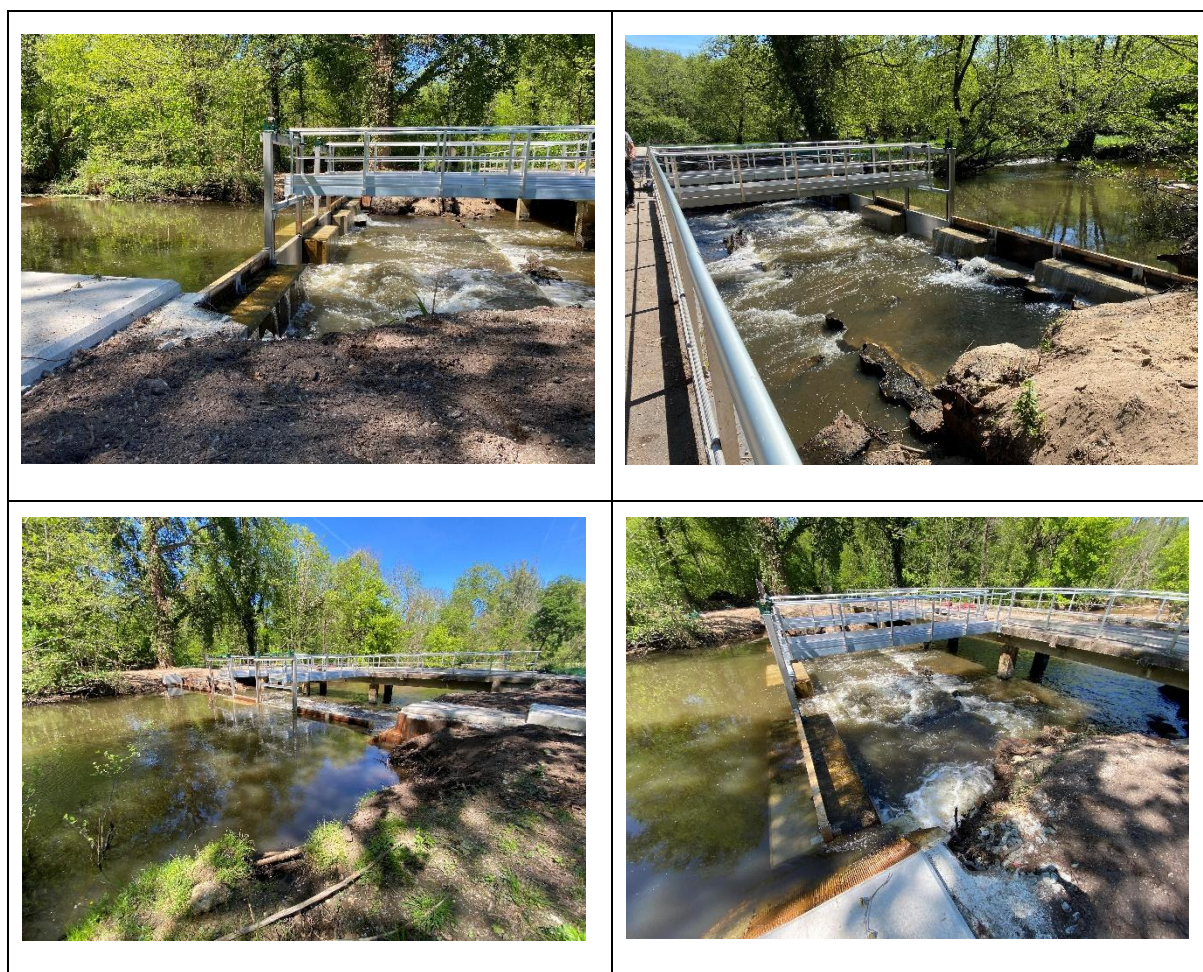
Figure 7 : Rapport photographique de l'ouvrage palplanche exécuté
