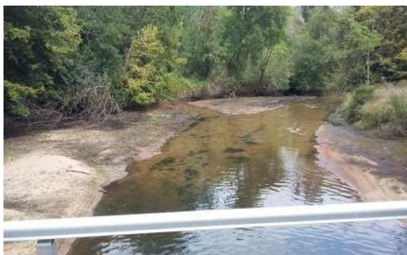
Figure 35 Dépôts sableux du lit de la Jalle en aval immédiat de l'ouvrage OH P
