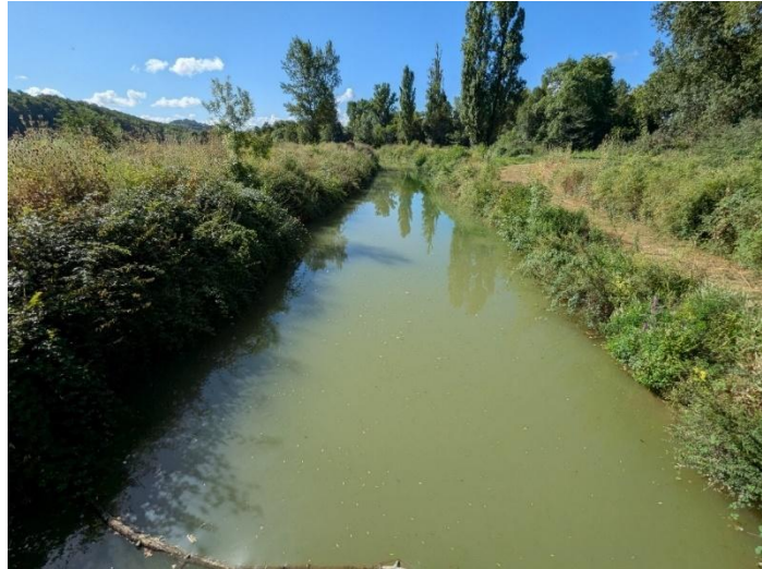
Figure 5: Photo du canal d'amenée en amont de la prise d'eau
