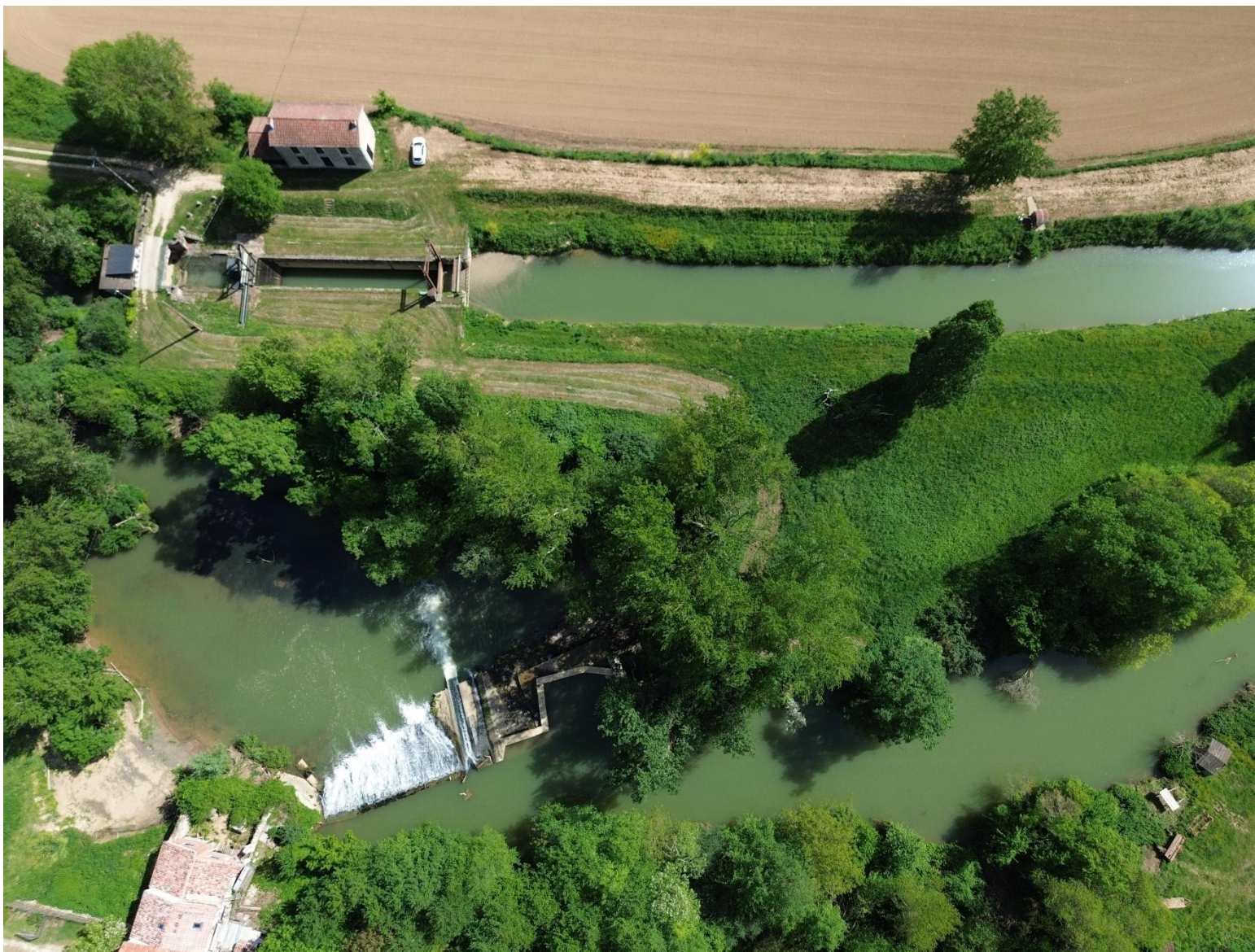
Figure 2 : Zoom sur la centrale hydroélectrique de Camarade (Photo du 22/04/26)
