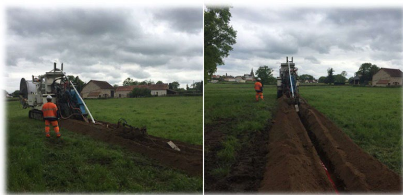
Exemple de chantier d’enfouissement d’un réseau électrique en terres agricoles (source : Cegelec Infra)
