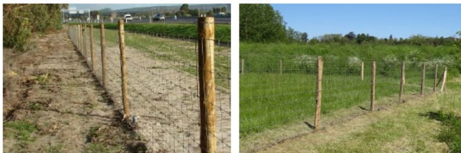
Figure 28 : Exemple d'une clôture de parc solaire – Source Melvan
