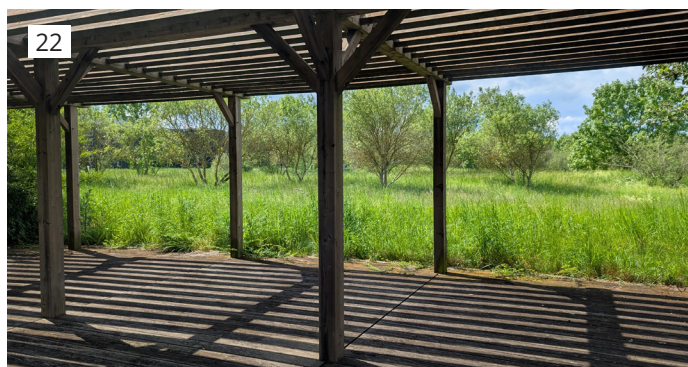
Fig.37 : Vue sur l'ancien bâtiment de restauration (TRANS-FAIRE, 2026)
