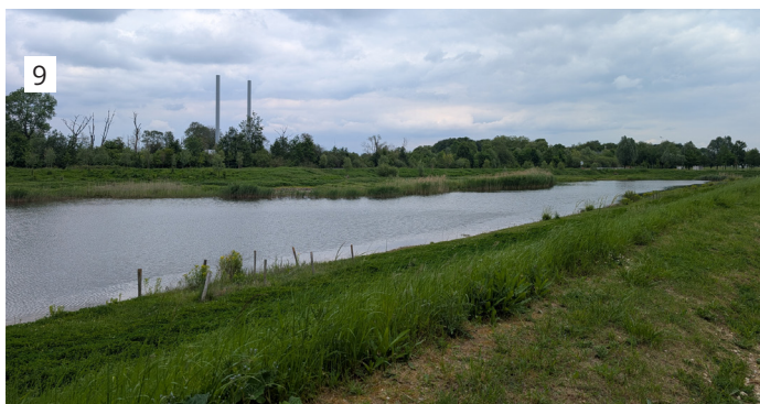
Fig.24 : Vue sur le bassin au nord du secteur depuis la rue Rosalind Franklin (TRANS-FAIRE, 2026)
