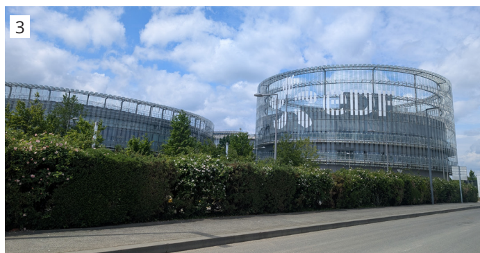
Fig.18 : Vue sur le bâtiment EDF depuis la rue Rosalind Franklin (TRANS-FAIRE, 2026)
