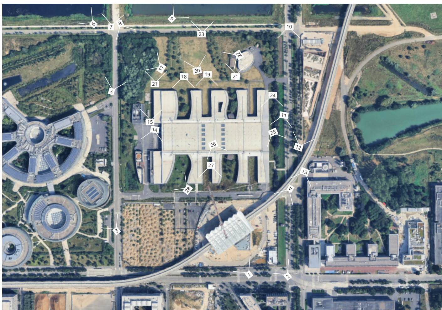
Fig.15 : Prises de vue de l'opération et de ses abords (Googlemaps, annotations TF, 2026)
