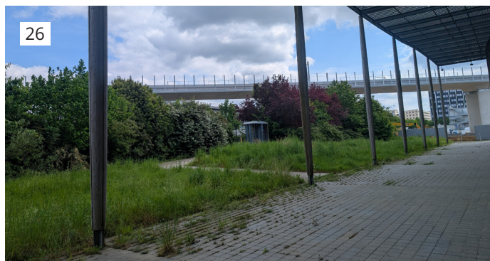
Fig.41 : Vue depuis l'entrée principale de l'ancien site Danone (TRANS-FAIRE, 2026)
