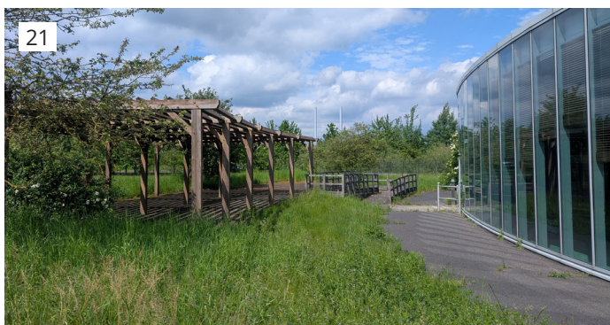
Fig.36 : Vue sur l'ancien bâtiment de restauration (TRANS-FAIRE, 2026)
