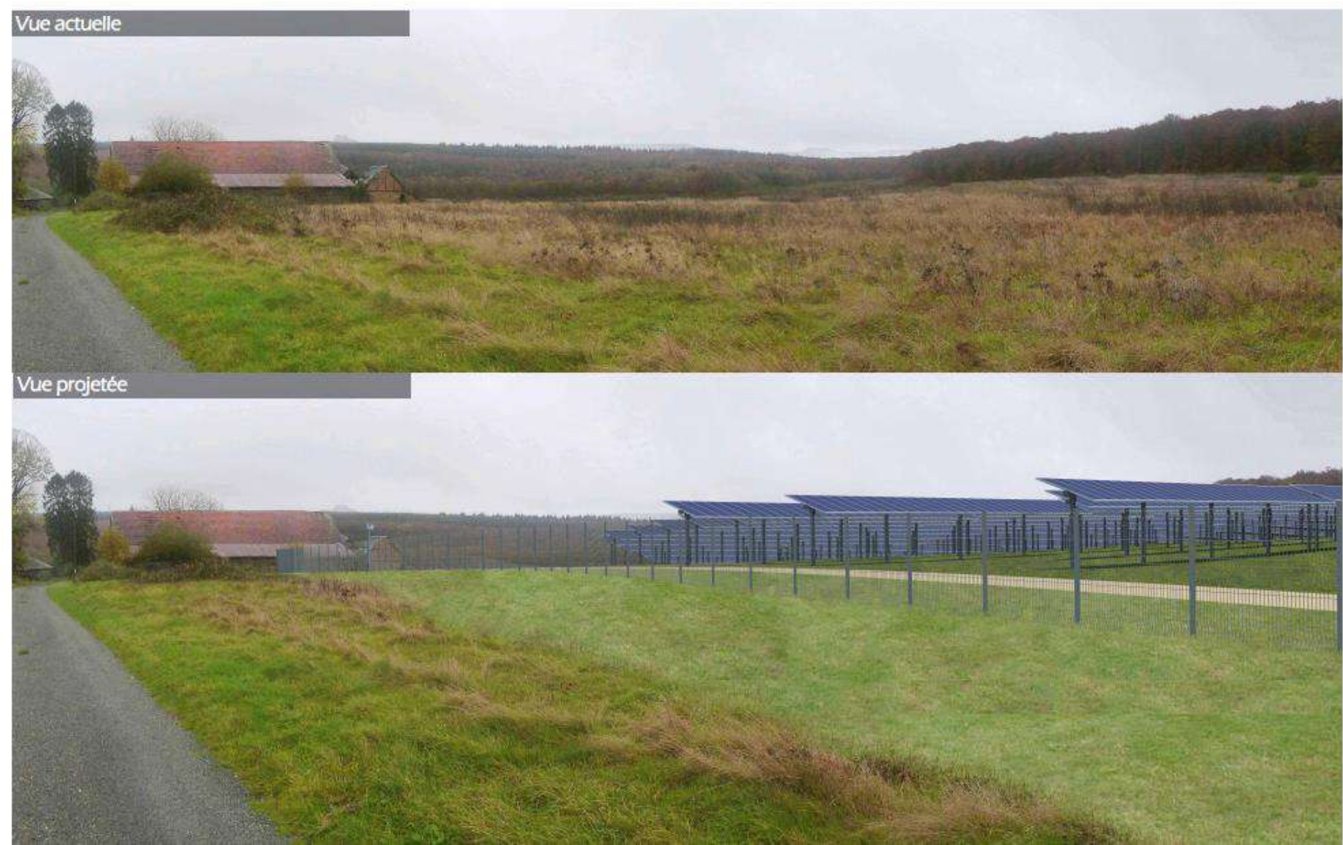
Photomontage 2 : vue depuis le chemin d'accès au hameau Le Chailloux en direction du Sud-Est
