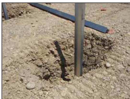
Figure 16 : Types de fondation - pieux battus (Source : Guide MEDDTL 2011 – NCA, 2015)
