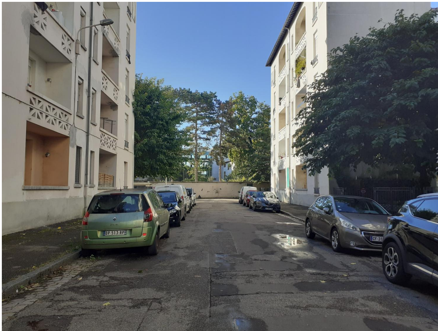
2. Vue de la rue de l'Effort (octobre 2024) – sens nord-Sud
