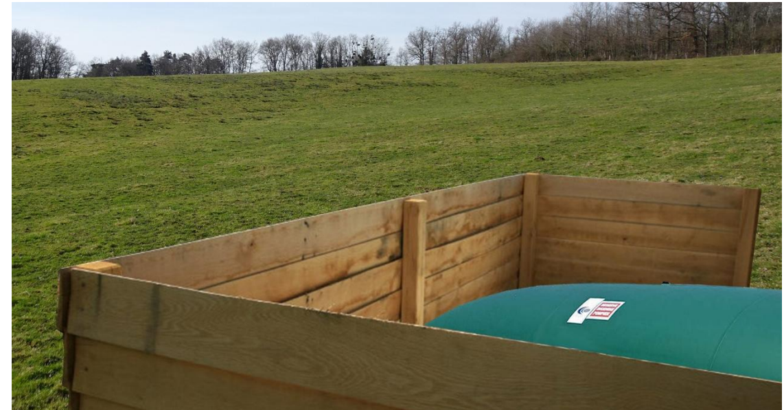
Figure 12 : exemple d'une citerne incendie bardée bois
