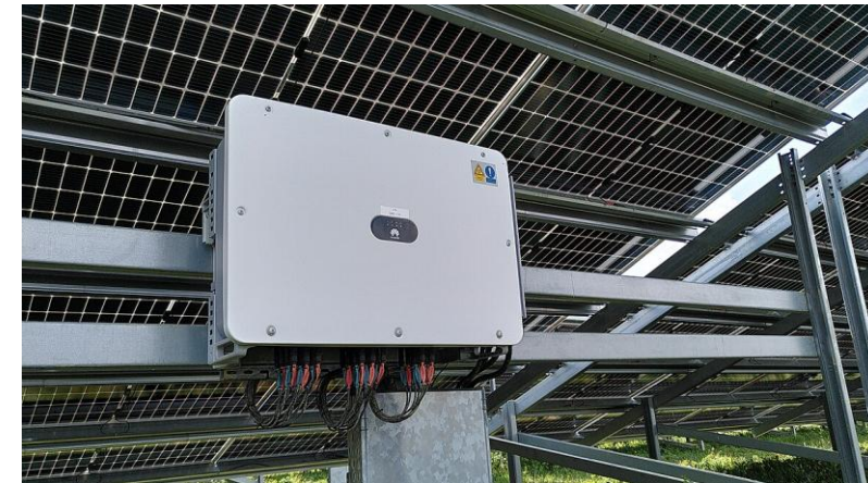
Figure 10 : onduleur string (image wikimedia commons)
