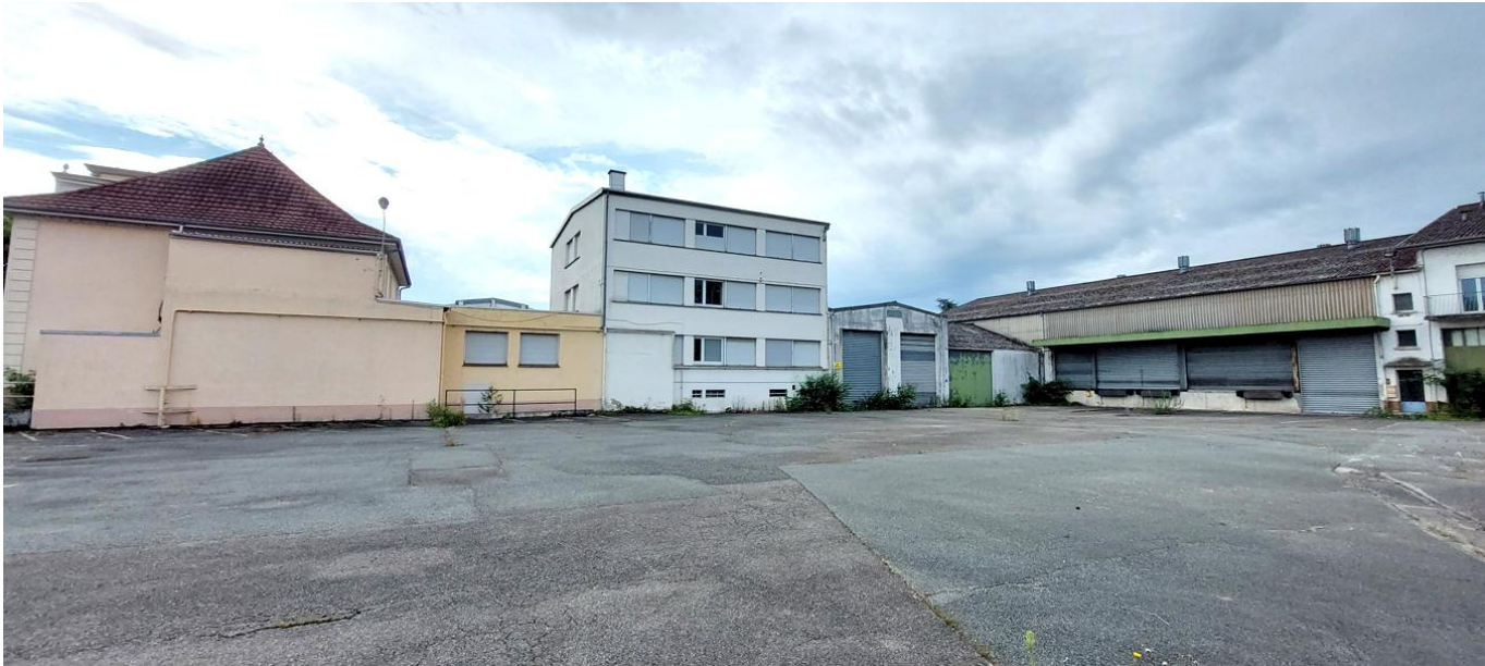
Photo 1 : Etat actuel du site du projet : prise de vue A (photos du 25/07/2025)
