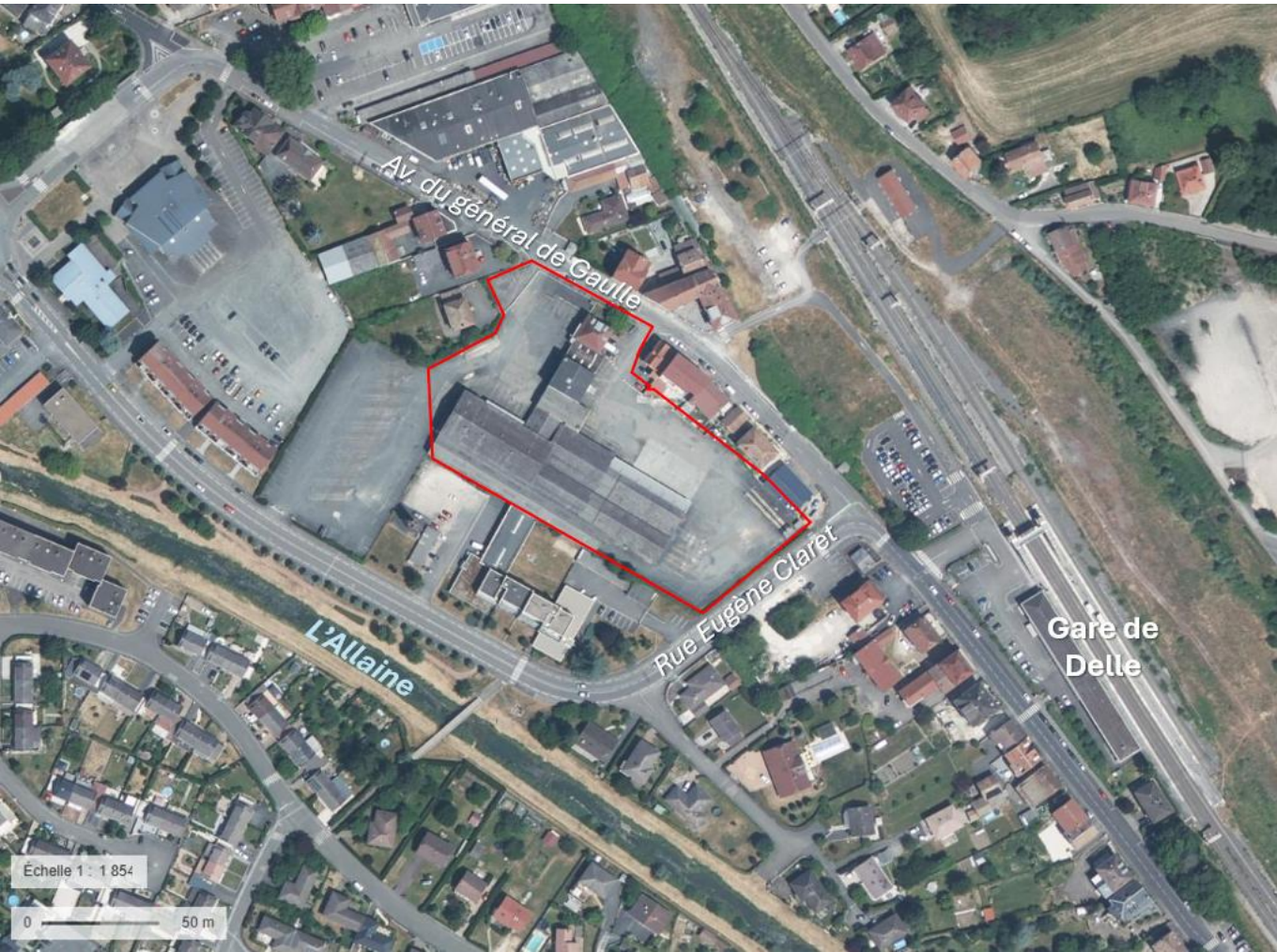
Figure 2 : Localisation du projet sur la photo aérienne (1/2000°)
