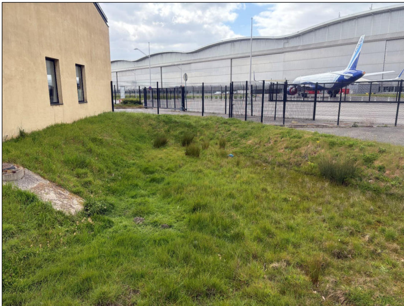
Figure 7 – Vue au point 3bis : Bassin de rétention qui sera retravaillé avec casiers enterrés
