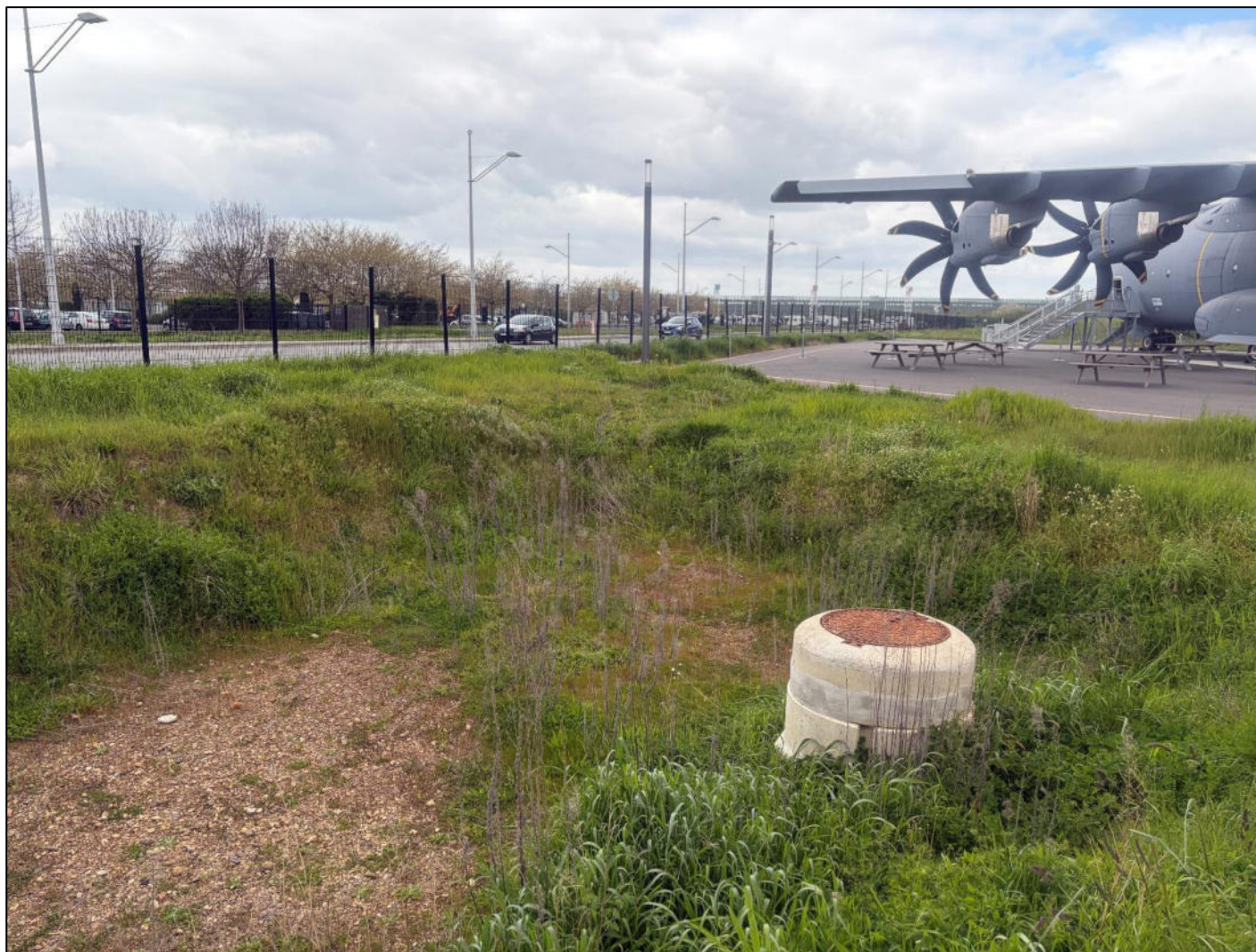
Figure 9 – Vue au point 5 : Bassin de rétention qui sera retravaillé avec tranchée drainante
