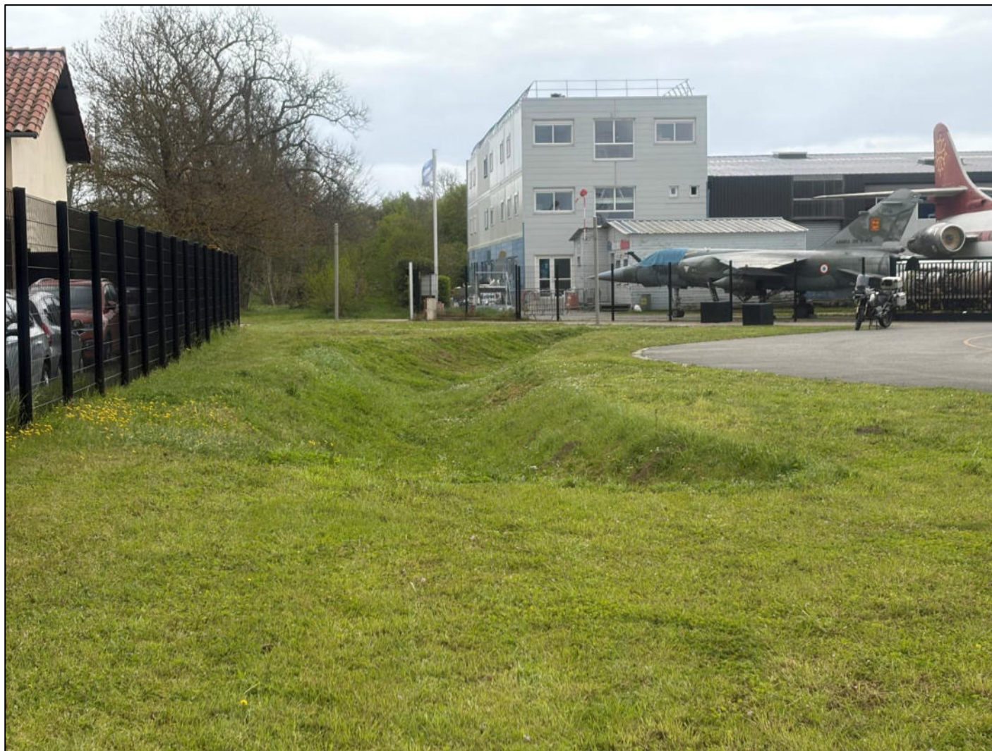
Figure 8 – Vue au point 4 : Bassin de rétention qui sera redimensionné légèrement à la hausse
