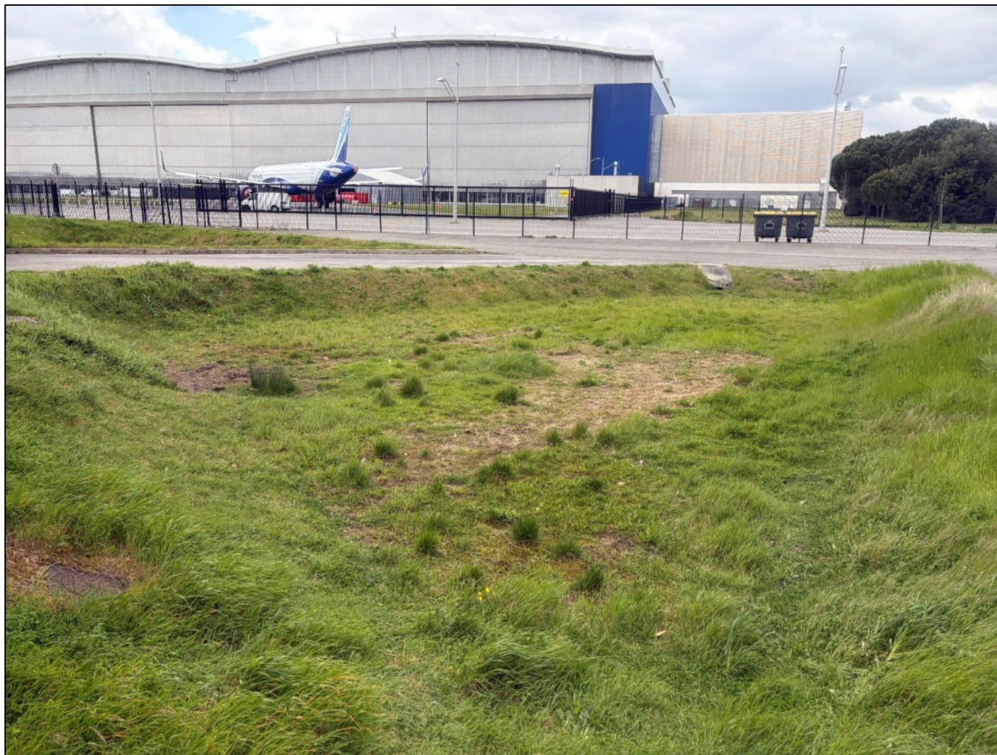
Figure 6 – Vue au point 3 : Bassin de rétention qui sera retravaillé avec zone drainante
