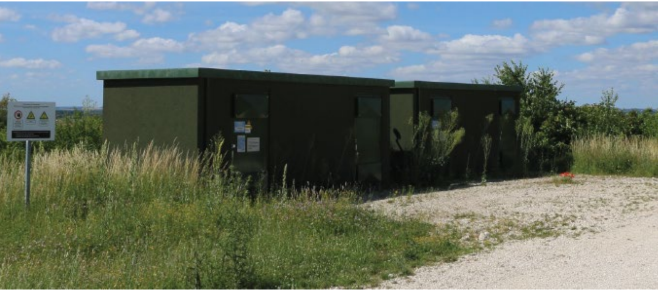
Figure 11 : Exemple de poste de livraison (source : Ater-Environnement, 2024)
