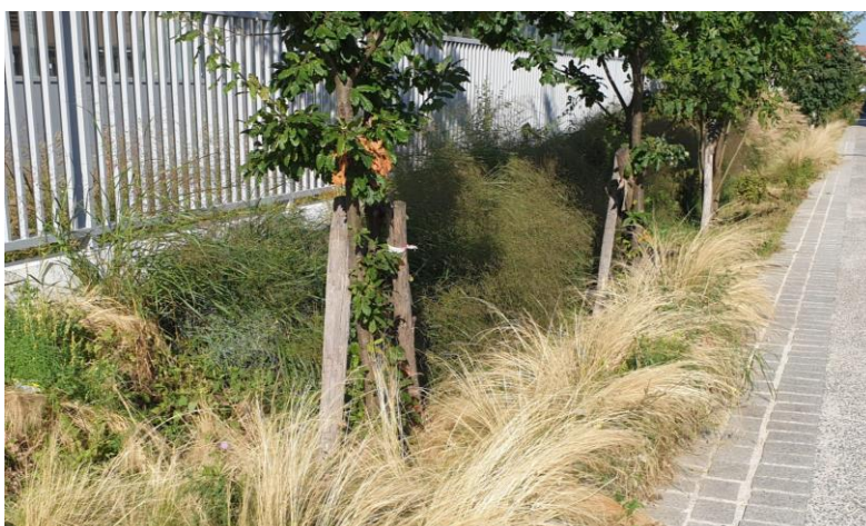
Exemple de fossé/noue paysagère
