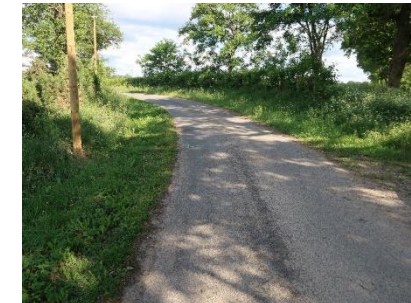
Route communale Source : ARTIFEX 05/2022
