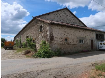
Lieu-dit « Lavaud » Source : ARTIFEX 05/2022
