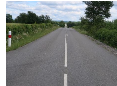
Route départementale D1 Source : ARTIFEX 05/2022
