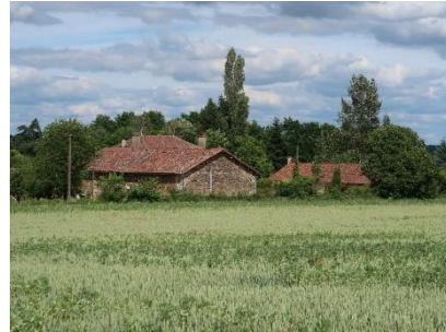
Lieu-dit « le Logis » Source : 05/2022
