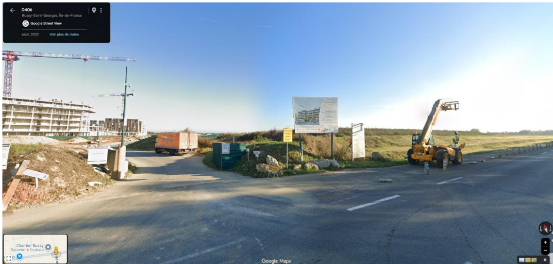
Vue 3 – Départementale 406 vers nord (Photo Google Street septembre 2022)
