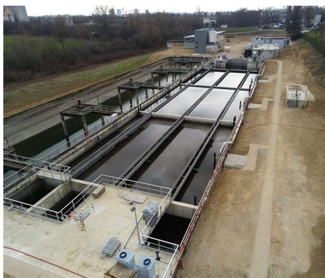
Réacteurs NEREDA – technologie de la boue granulaire
