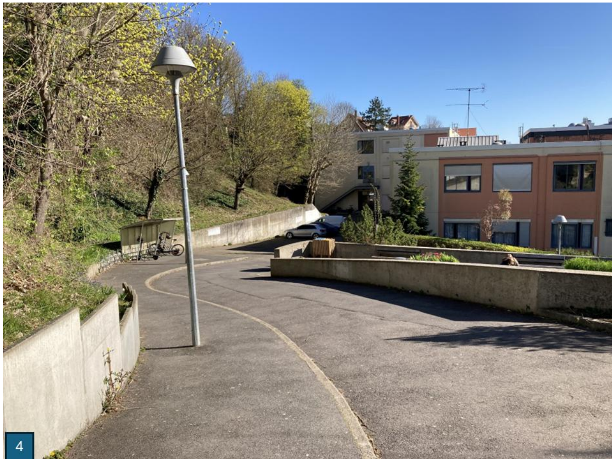
Partie Basse – après le portail, accès vers le bâtiment A
