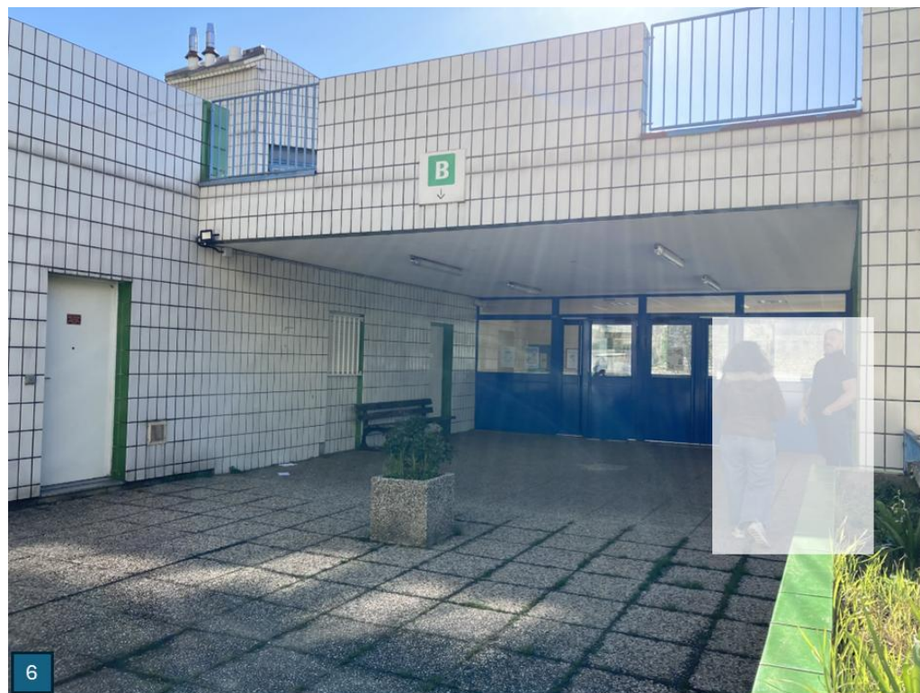
Partie Basse – bâtiment A
