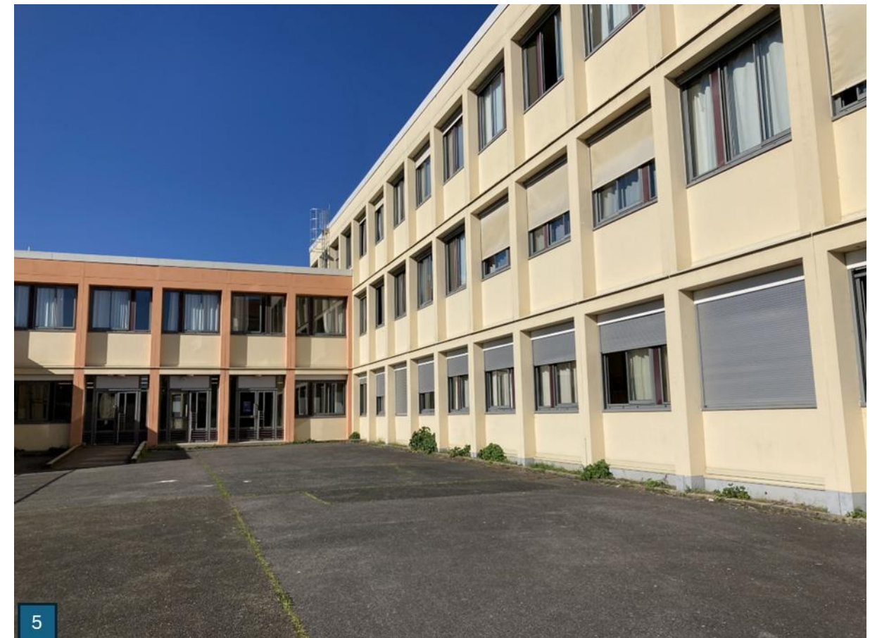
Partie Basse – bâtiment A
