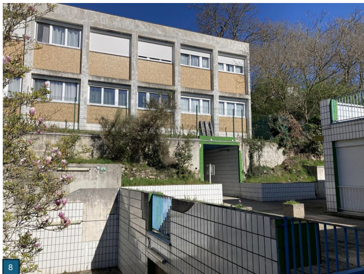
Partie Basse – logements de fonction
