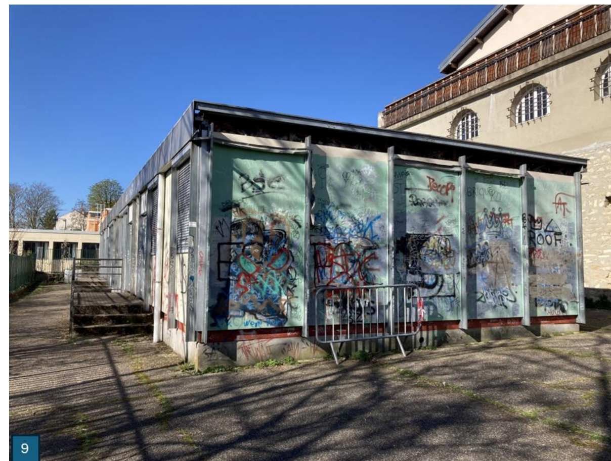
Partie Basse – bâtiment préfabriqué
