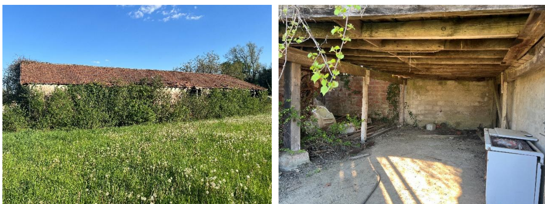
Bâti présent sur site (BKM, 2026)
