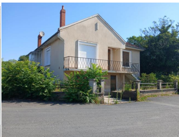
Vue extérieure de la maison d'habitation localisée sur la parcelle CK 27
