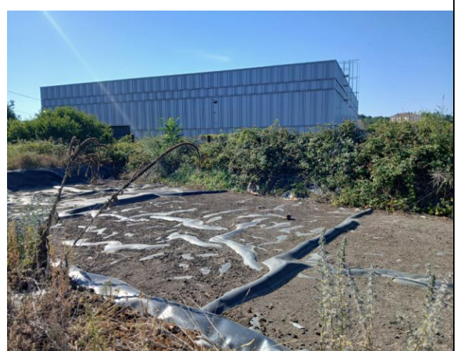
Vue du bassin de rétention localisé en limite Sud du site
