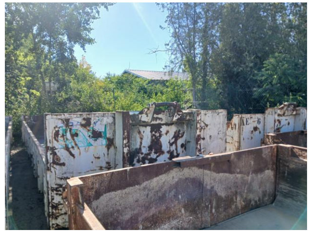
Vue de la limite Nord-est du site derrière les bennes
