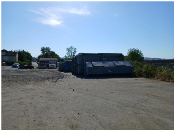
Vue de l'entrée du site depuis l'angle Sud-Ouest – Aperçu de la zone traitée S3
