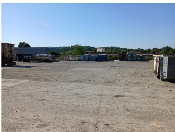
Vue globale du site depuis la bordure Nord en direction du Sud du site – Aperçu au sol de la zone traitée S15
