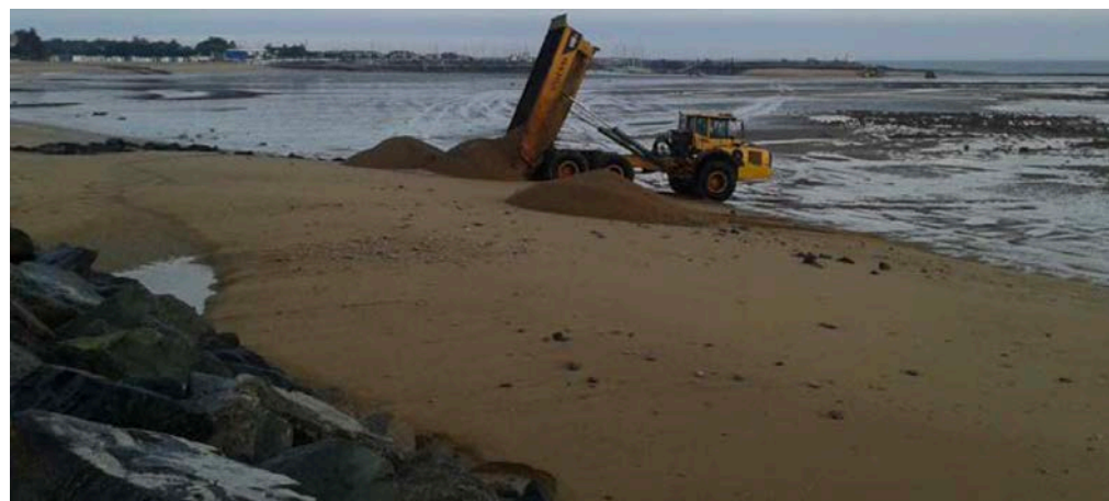
Fig. 4 - Exemple non contractuel d'opération de rechargement de plage
