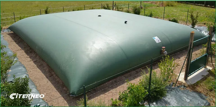
Exemple de citerne incendie (bâche souple) de la marque « Citerneo »
