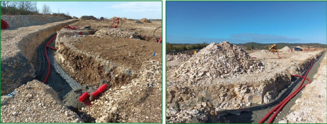
Mise en place des câbles électriques de raccordement interne au sein de tranchées préalablement creusées
