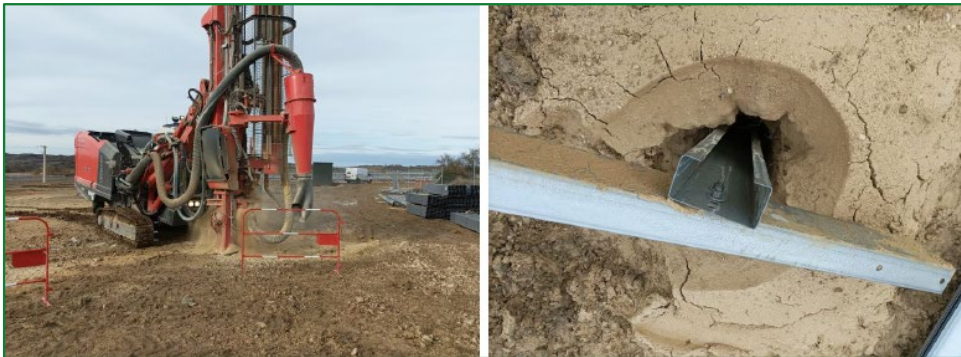
Forage et implantation de pieux d'ancrage
