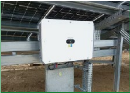
Onduleur décentralisé
