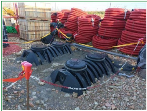
Stockage de matériel et cuves d'eau enterrées sur une base vie de chantier
