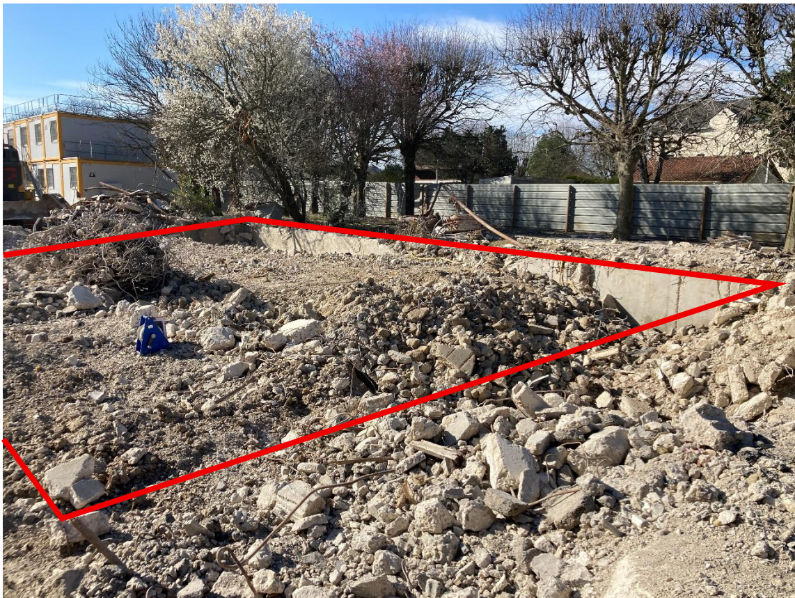
(6) Photographie du local chaufferie démolie et comblé. Emprise initiale en rouge.. (03/03/2026)
