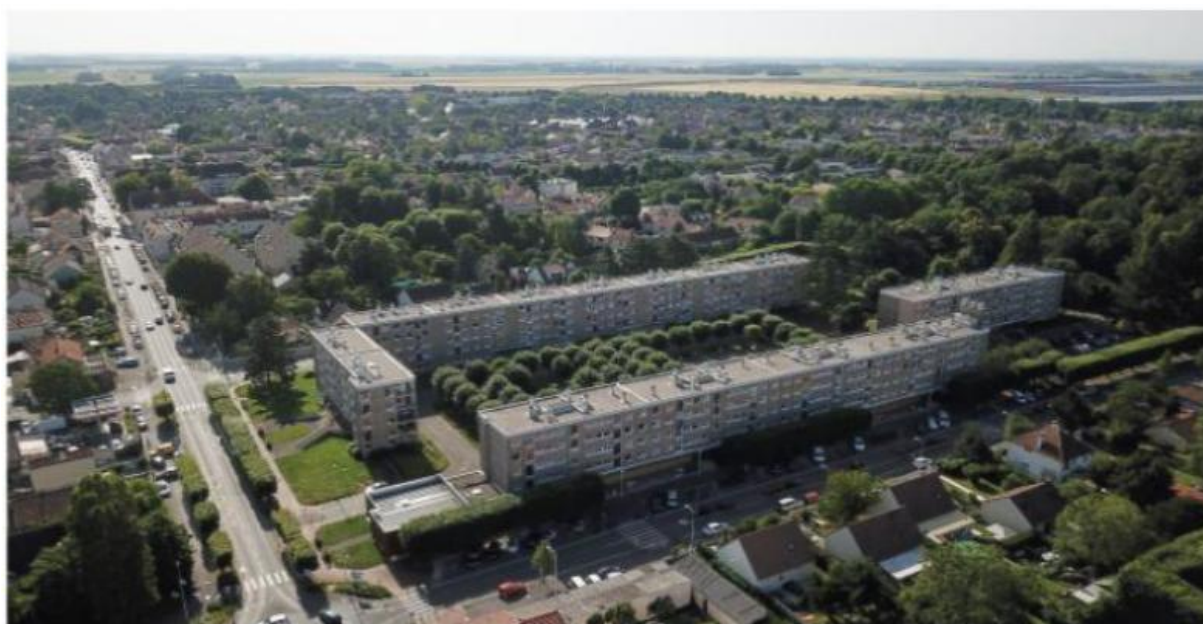
Photo 15 - Vue aérienne du quartier avant relogement des habitants
