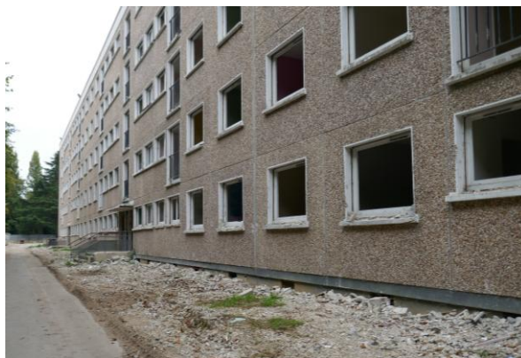
Photo 4 — Bâtiment en cours de démolition (©Alisea/A.Delauze)
