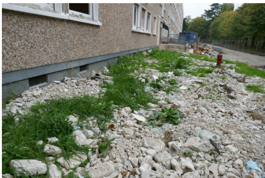
Photo 5 — Dépôts de gravats de démolition (©Alisea/A.Delauze)
