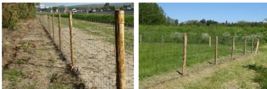
Figure 22 : Exemple d'une clôture de parc solaire
