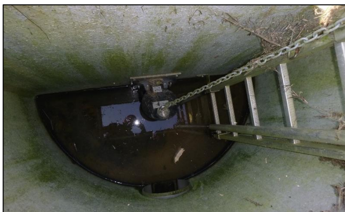
Figure 2 : Exemple d'une vanne à chaînette dans un ouvrage de sortie de bassin d'orage
