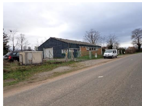
Bâtiment en limite sud-ouest du site d'étude Source : Artifex 2024
