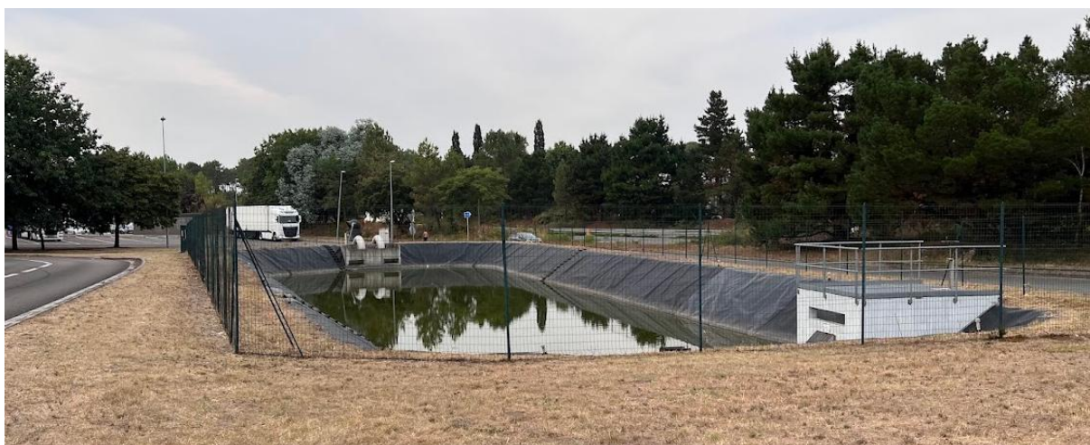
Figure 20 : Photographie du bassin présent sur site (source : SP Architecte, 2026)
