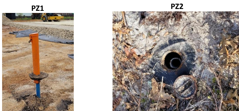
Figure 8 : Photographie des piézomètres trouvés à proximité du site d'étude
