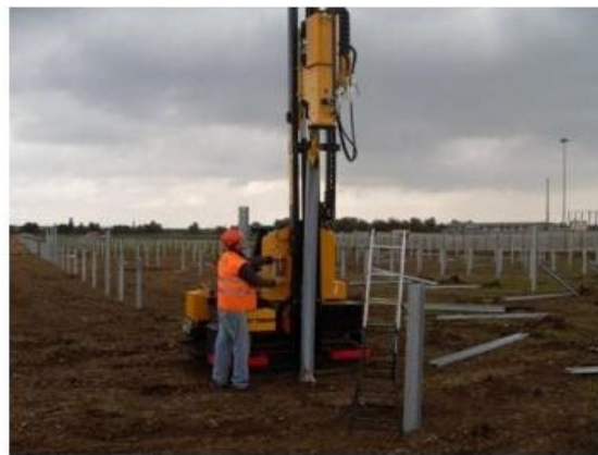
Figure 6 : Exemples de structures fixes et fondations par la méthode des pieux battus
