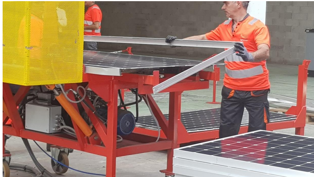
Figure 7 : Décadage des modules
