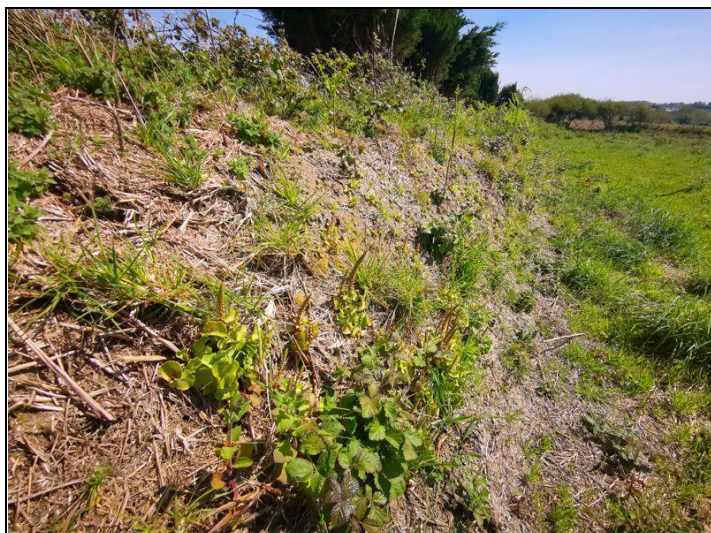
Photo 13 : Aspect du talus Est de 0073 après fauche en hiver.
