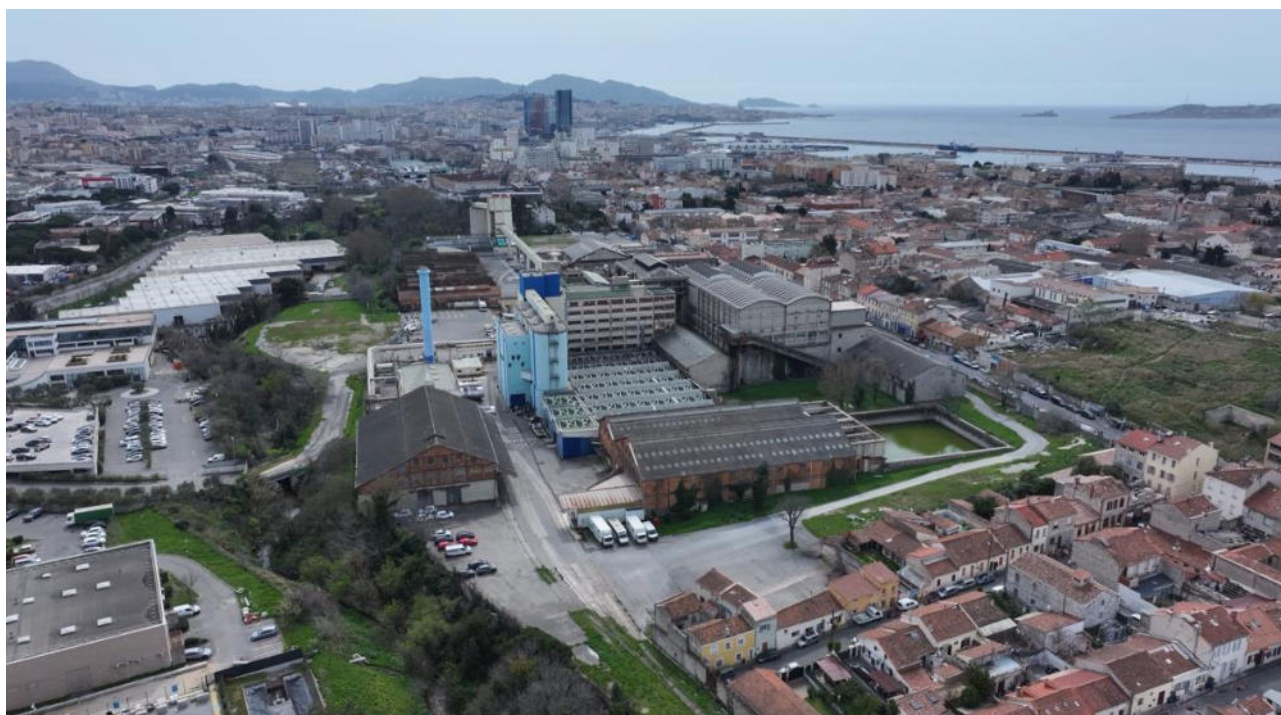
Figure 18 : Site avant démolition (Source : permis de construire)
